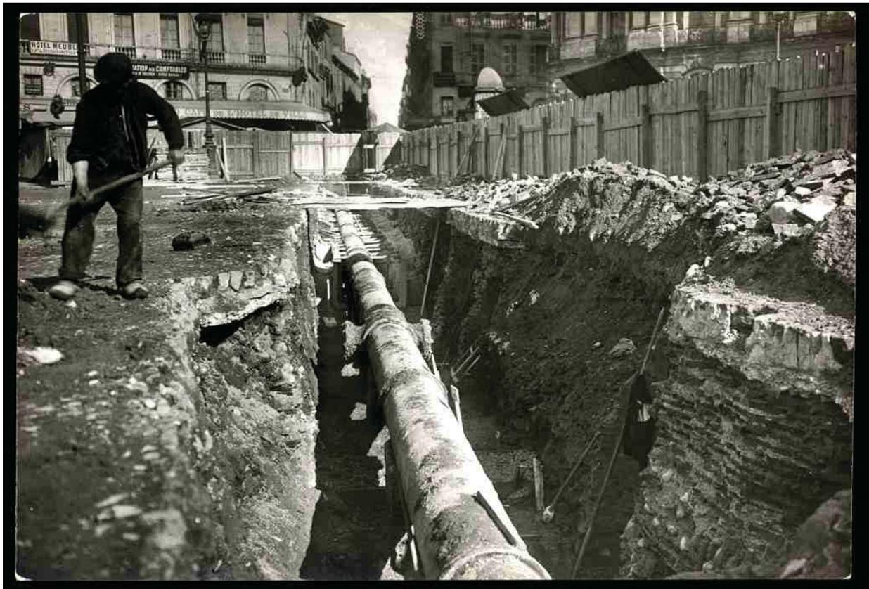
Fig. 7 : L. Fachinetti, Pose de canalisation d'égouts place du Capitole, 1910. Epreuve sur papier, 11x16 cm/ Archives municipales de Toulouse, 1Fi234. (en bas à droite : élément du rempart antique mis au jour lors des travaux).
