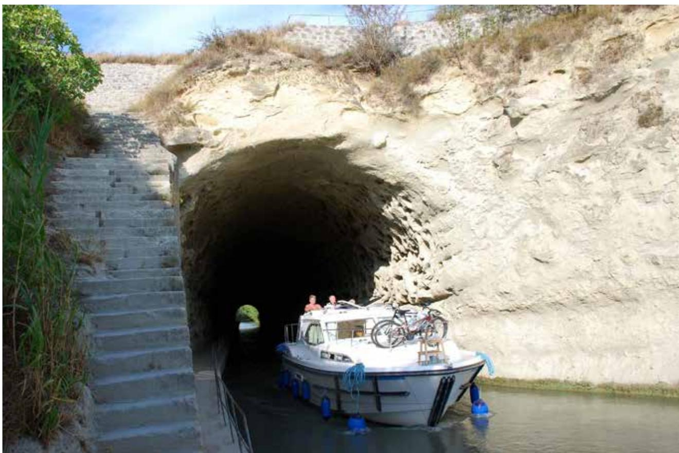
Fig. 2 : Le tunnel de Malpas et sa banquette utilisée autrefois au tirage des barques
